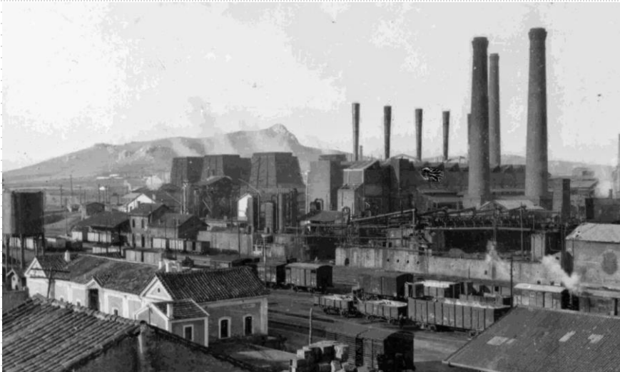
Cerco industrial en Peñarroya-Pueblonuevo
