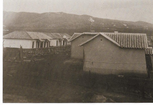
Barrio obrero de la Electromecánicas. Instalación de las conducciones de agua.
